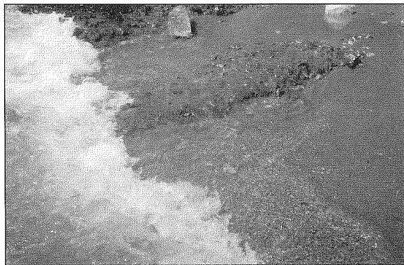
Εικ. 8. Λιμνή Μεσογαίας, αρχαία Στειριά: Ανατολικός λιμενοβραχίονας αρχόμενος από την ακτή. Φωτ. Αικ. Ταγωνίδου, Σεπτέμβριος 1998.
