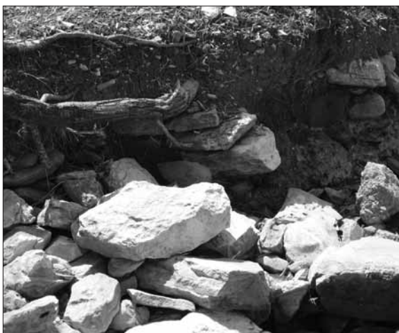
Εικ. 49. Μετόχι. Τοίχι στην ακτή της χερσονήσου.
