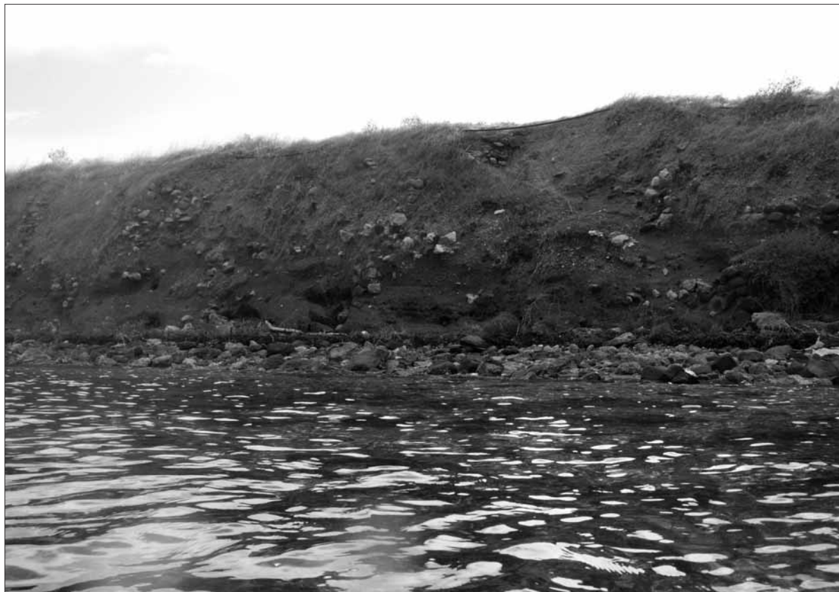
Εικ. 9. Κουρτήρ. Άποψη του πρηνούς, με ίχνη τοίχων διαφόρων φάσεων.
