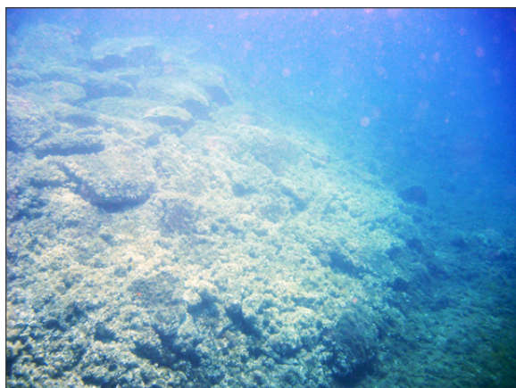
Εικ. 7. Παλαιόπολη Άνδρου. Η βάση της λιθορριπής του υπήνεμου λιμενοβραχίονα στον αμμώδη πυθμένα στην περιοχή της εισόδου (©ΕΕΑ – Λήψη Θ. Θεοδούλου).
